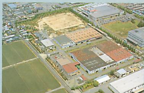
滋賀工場(滋賀県近江八幡市)
