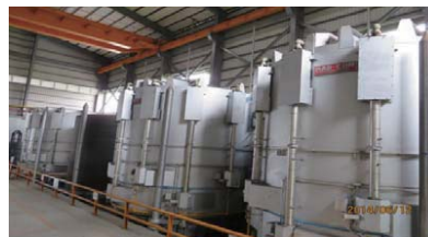
焼きなまし炉
